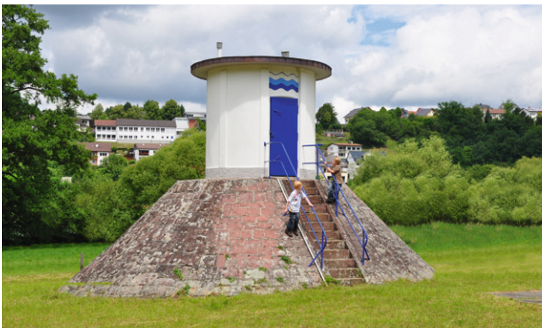
Schutz einer Wassergewinnungsanlage in Obrigheim
