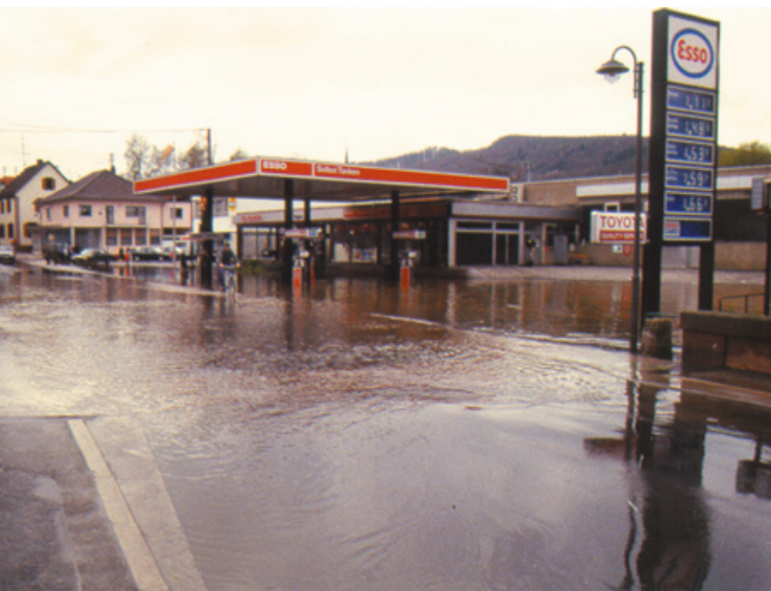
Von Anlagen zum Umgang mit wassergefährdeten Stoffen geht im Hochwasserfall eine hohe Gefährdung für die Umwelt aus.
