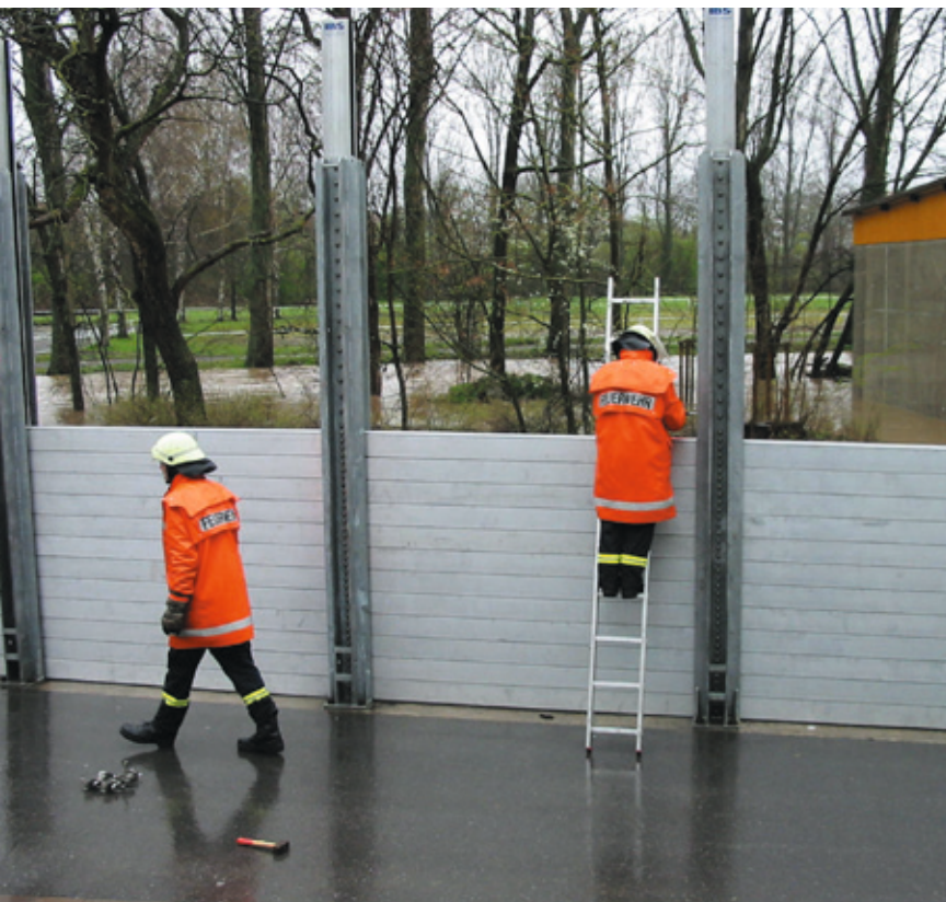
Hochwassereinsatz in Bad Friedrichshall
