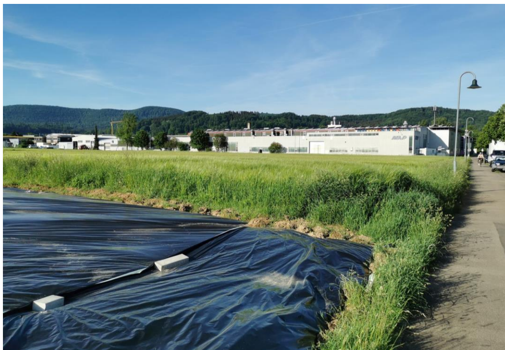
Abb 6. Blick von Nordwesten in Richtung Süden auf das Plangebiet, Quelle: mquadrat
