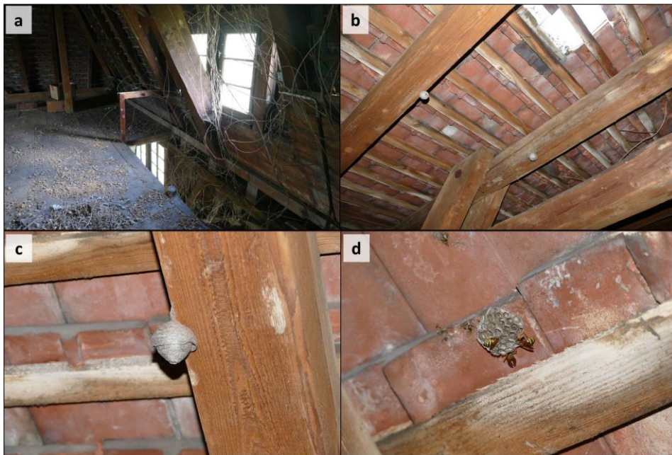
Abb 3: Untersuchung des denkmalgeschützten Hauses. a) Das Haus umfasst mehrere Zwischenstockwerke, die über alte Holzstiegen begehbar sind. Die Räume sind ungenutzt. b) Blick auf das Dach im obersten Stockwerk. Auf den ersten Blick fielen mehrere alte und neue Wespennester auf. c) Detailaufnahme eines der verlassenen Wespennester. d) Detailaufnahme eines der bewohnten Wespennester mit drei Individuen. Fotos: Dr. B. Schalkhaußer
