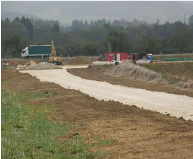
Die B 10-neu-Baustelle hat die Gemarkung erreicht
