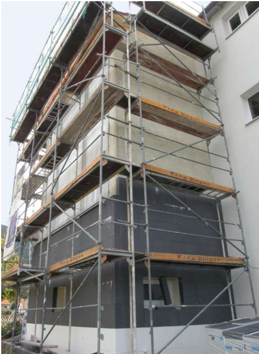
Wärmeschutzmaßnahmen am Treppenhaus von Bauteil 1
