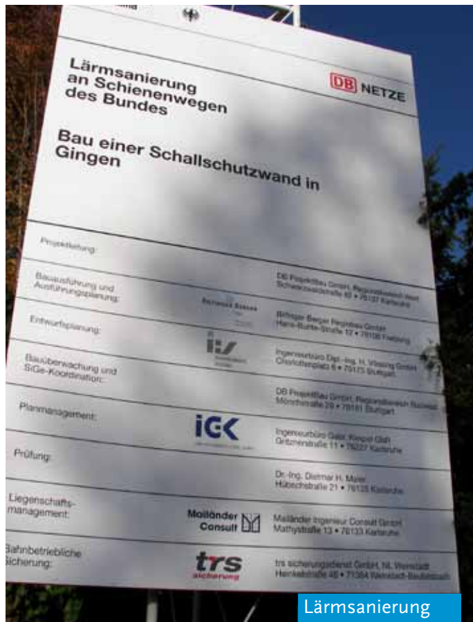
Bau der Schallschutzwand Lärchenweg/Hohensteinstraße
