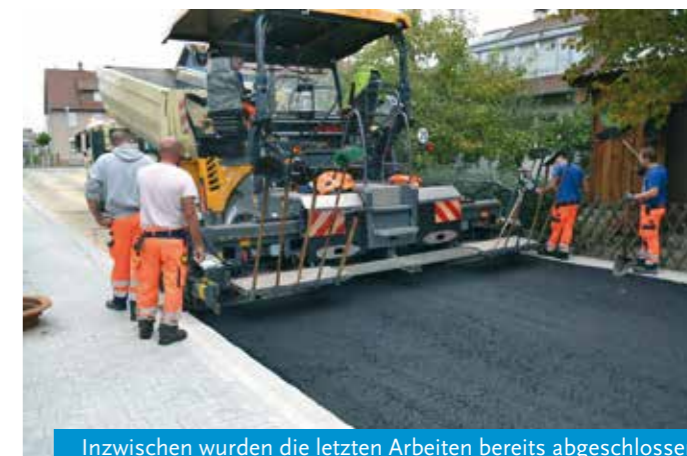
Inzwischen wurden die letzten Arbeiten bereits abgeschlossen
