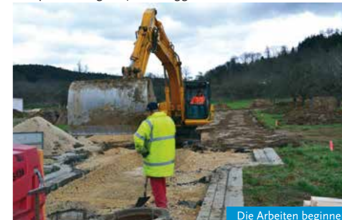
Die Arbeiten beginnen
