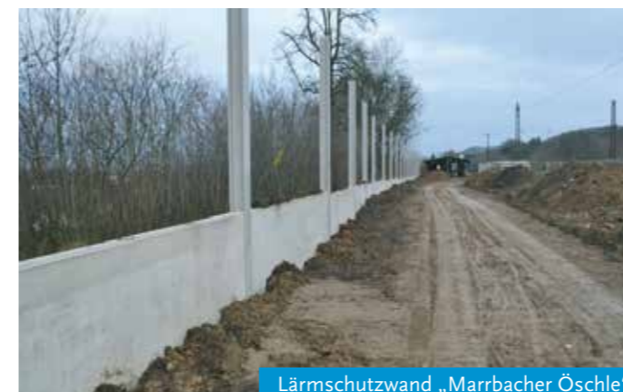
Lärmschutzwand „Marrbacher Öschle“
