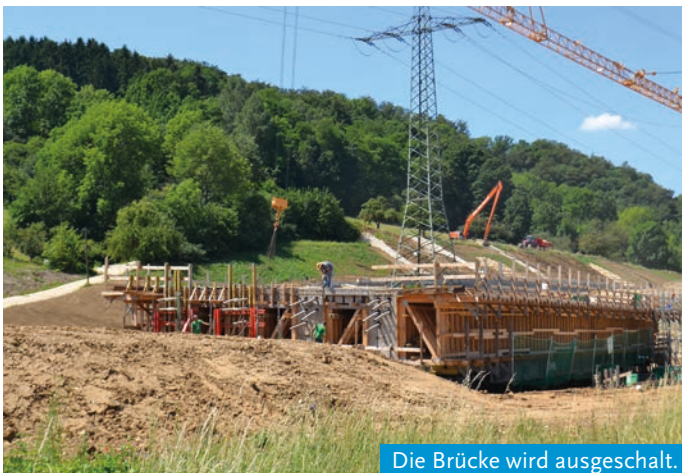
Die Brücke wird ausgeschalt.
