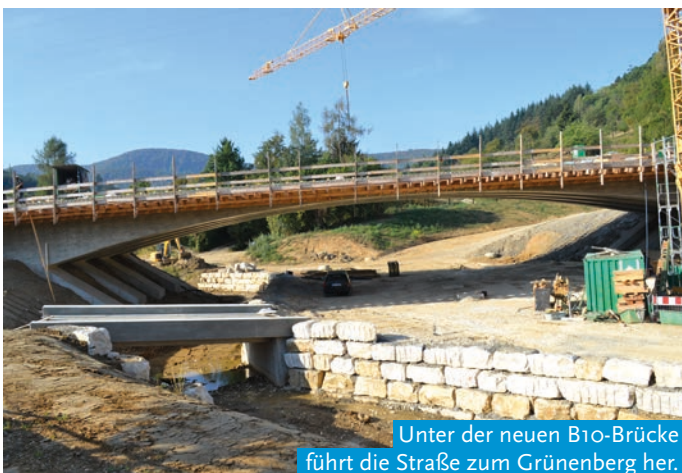
Die Brücke wird ausgeschalt.
