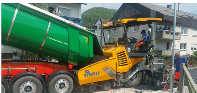
Die Arbeiten gingen zügig voran – die Straßenarbeiten lagen sogar 3 Wochen vor dem Zeitplan
