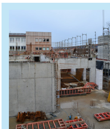
Im Außenbereich wurde mit der Herstellung des "VHS Eingangs" begonnen
