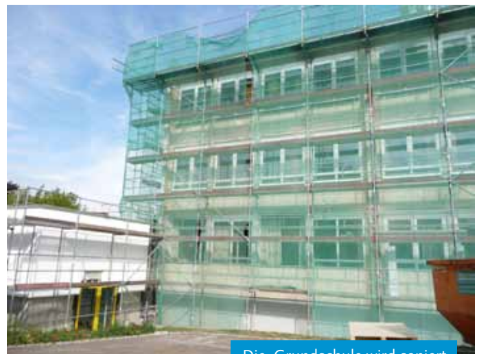
Die Grundschule wird saniert
