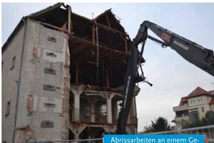
Abrissarbeiten an einem Gebäude der Firma Buchsteiner
