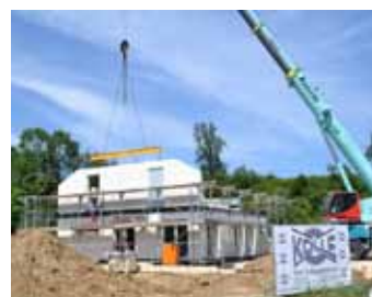
Das erste Haus im Marrbacher Öschle entsteht.
