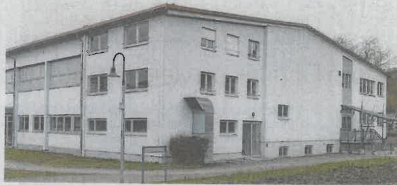
Die Hohensteinhalle in Gingen stammt aus den 60er Jahren und soll im Januar abgerissen werden. Foto: Markus Sontheimer
