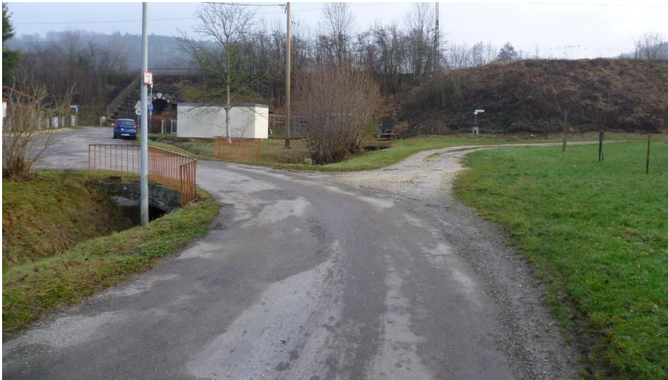
Abb 5. Blick entlang Donzdorfer Straße nach Osten auf Teilfläche 2.
